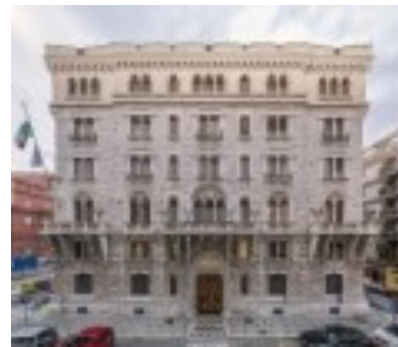
IL PALAZZO DELL'ACQUEDOTTO PUGLIESE A BARI
