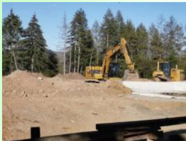
Lavori di bonifica al sito dell'ex complesso industriale "PPK Velebit" a Gospić. Foto: Saša Leković
